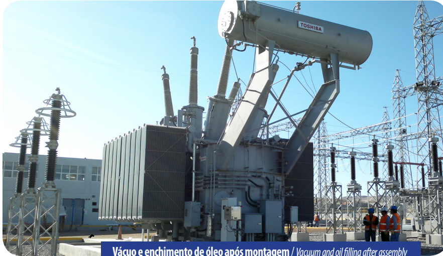
Vácuo e enchimento de óleo após montagem / Vacuum and oil filling after assembly
